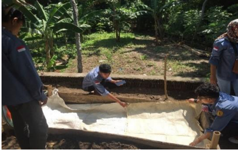
Gambar 2 Pemasangan alas karung
